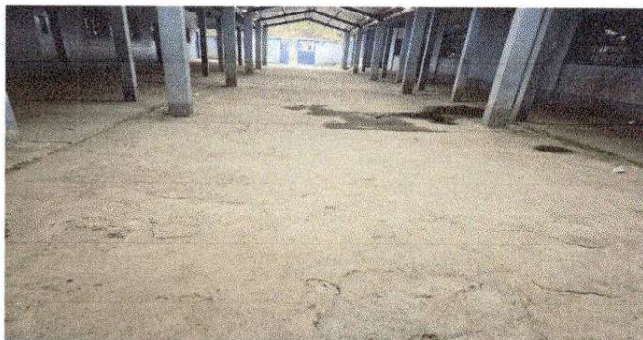
Foto1: Sustitucion de Piso de Torta de Concreto
