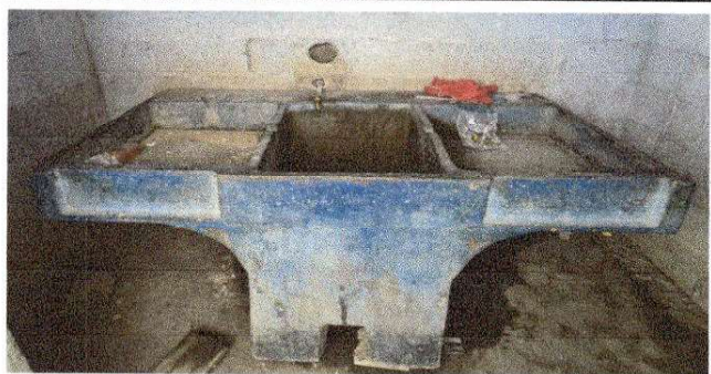
Foto 5: Sustitución de Llave de Chorro
