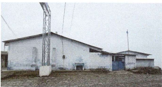
Foto 3: Pintura en Muros Exteriores e Interiores
