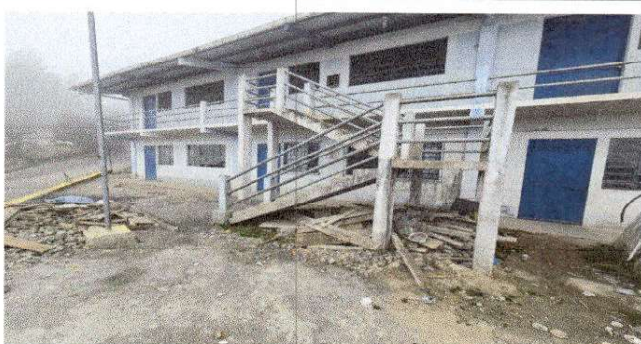
Foto 4: Pintura en Muros Exteriores e Interiores
